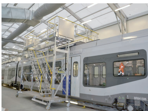
Passerelle mobile en situation, hauteur de plancher réglable de 3,46 à 4,46 m
