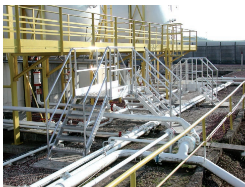
Passerelle de franchissement triple accès
