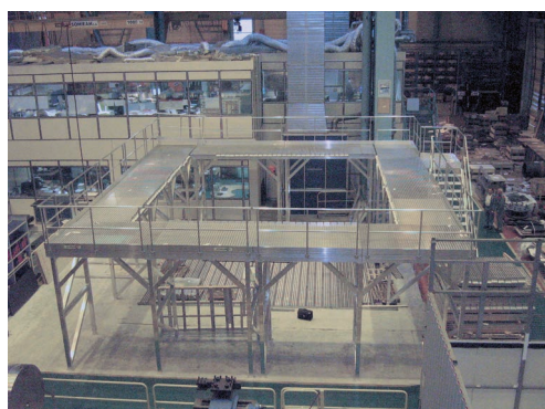
Passerelle d'assemblage machineries
